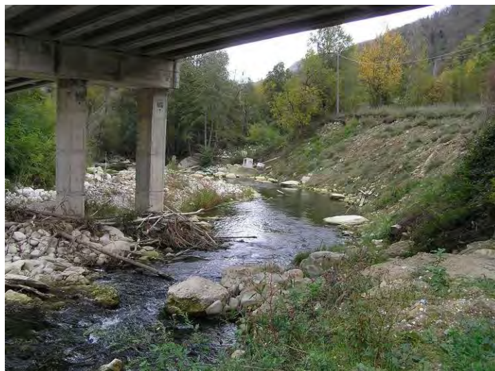
FIGURA 59 – FIUME TRONTO – STAZIONE ITTICA DI ARQUATA DEL TRONTO.
